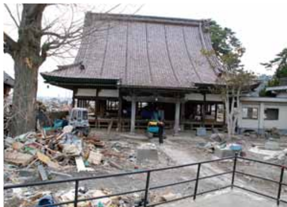
瓦礫の撤去が進んだ称法寺
